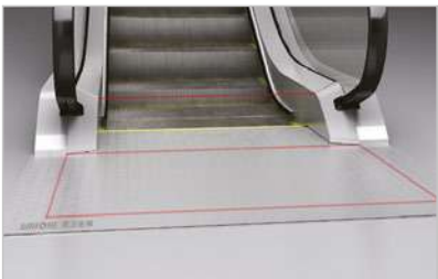
Встроенное верхнее и нижнее устье поручня и внутренняя защитная панель обеспечивают широкий диапазон чувствительности в зависимости от изменения пассажиропотока для достижения экономии энергии.
